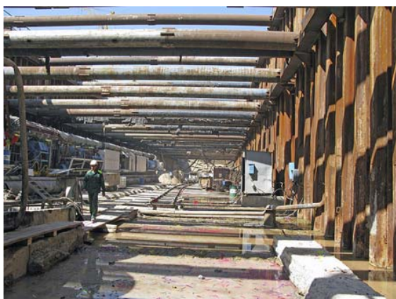
Ảnh 2: Gia cố thành hố móng đào mở
